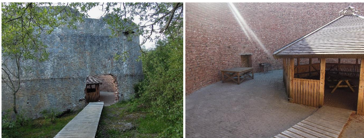
Figur 4.4. Ringmuren som tyskerne bygde rundt en oljetank under 2. verdenskrig. Grillhytta inni er laget av Lundsvågen naturskole.
